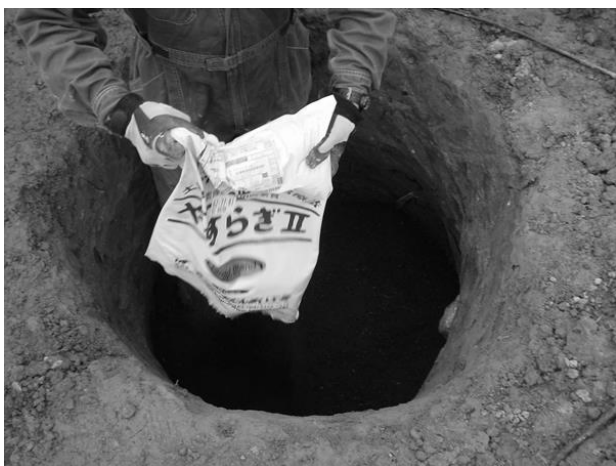
{ 写真 ⑥ 専用炭素質の埋設 }
